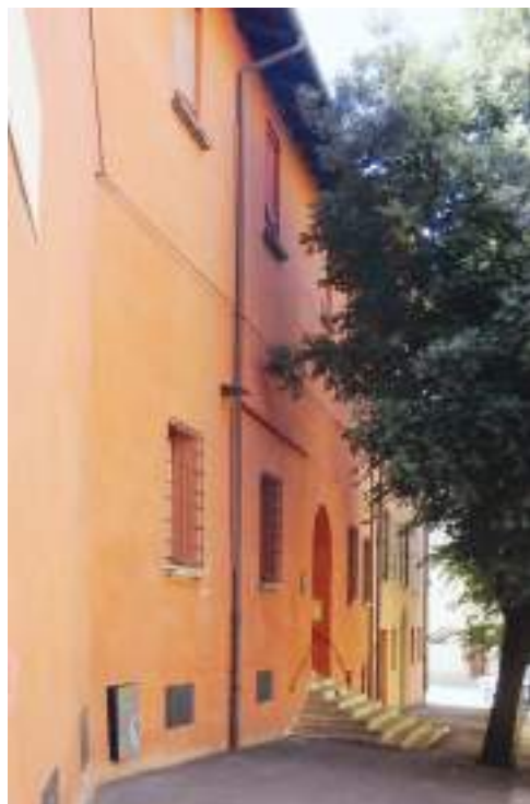
Bologna - S. Maria di Borgo Arienti Facciata su via Arienti (S)
